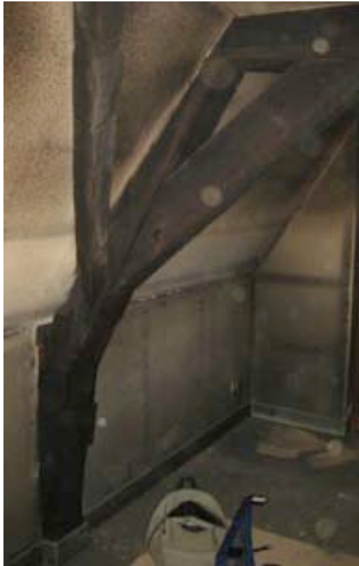
Korbeelstel op de tweede verdieping en kromstijl op zolder, zoals aangetroffen bij het begin van de herstelwerkzaamheden in maart 2012
