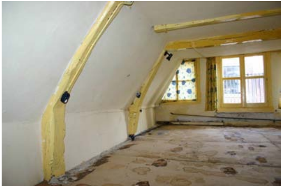
Warmoesstraat 40, kapconstructie van het voorhuis met hout dat rond 1550 werd gekapt (foto BMA).
