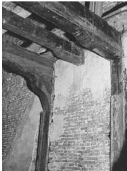
Heintje Hoekssteeg 26, alternerende balklaag met zwanenhalskorbelen, gebouwd in 1604 of 1605 (foto's BMA, opname 2012 en 1956).
