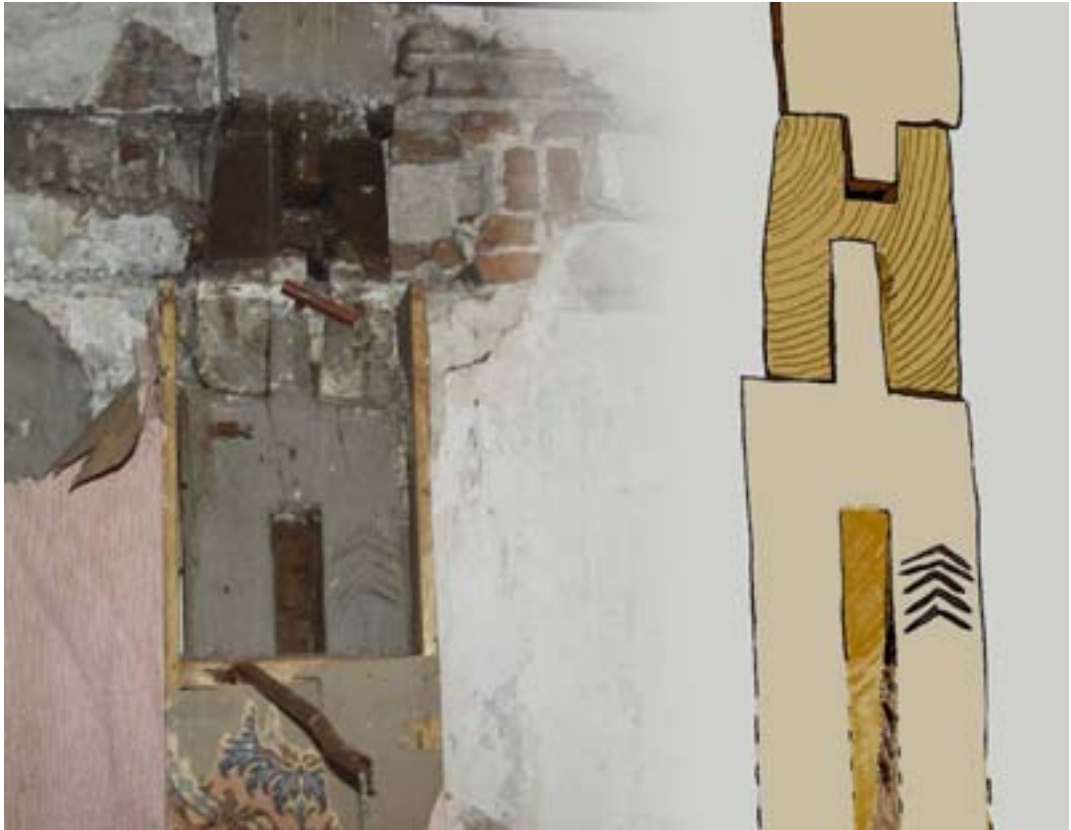
Telmerken op het oppervlak van de muurstijl, oorspronkelijk afgedekt door een korbeel (foto en bewerking Dik de Roon/ BMA).
