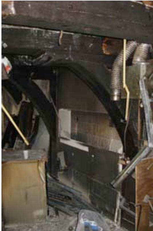
Korbeelstel op de tweede verdieping en kromstijl op zolder, zoals aangetroffen bij het begin van de herstelwerkzaamheden in maart 2012
