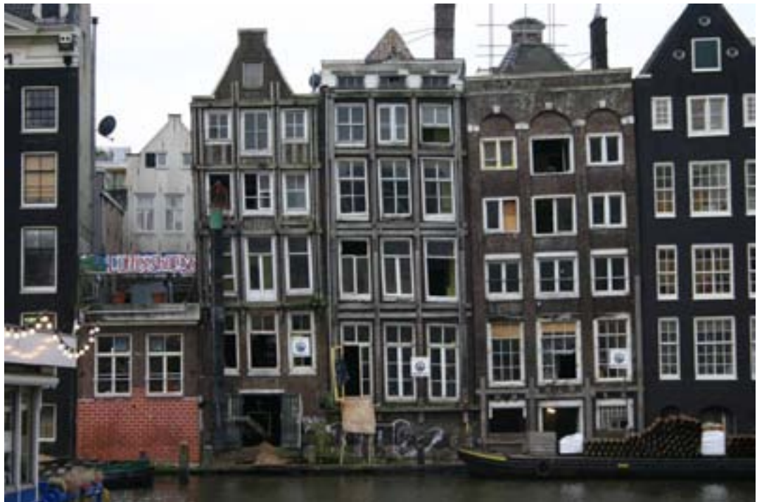
De drie achtergevels van 'Hotel Kabul' in 2006, voor de restauratie (foto BMA).
