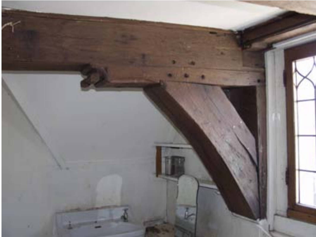
Peerkraalsleutelstuk met moerbalk, korbeel en muurstijl (foto BMA/ Dik de Roon).
