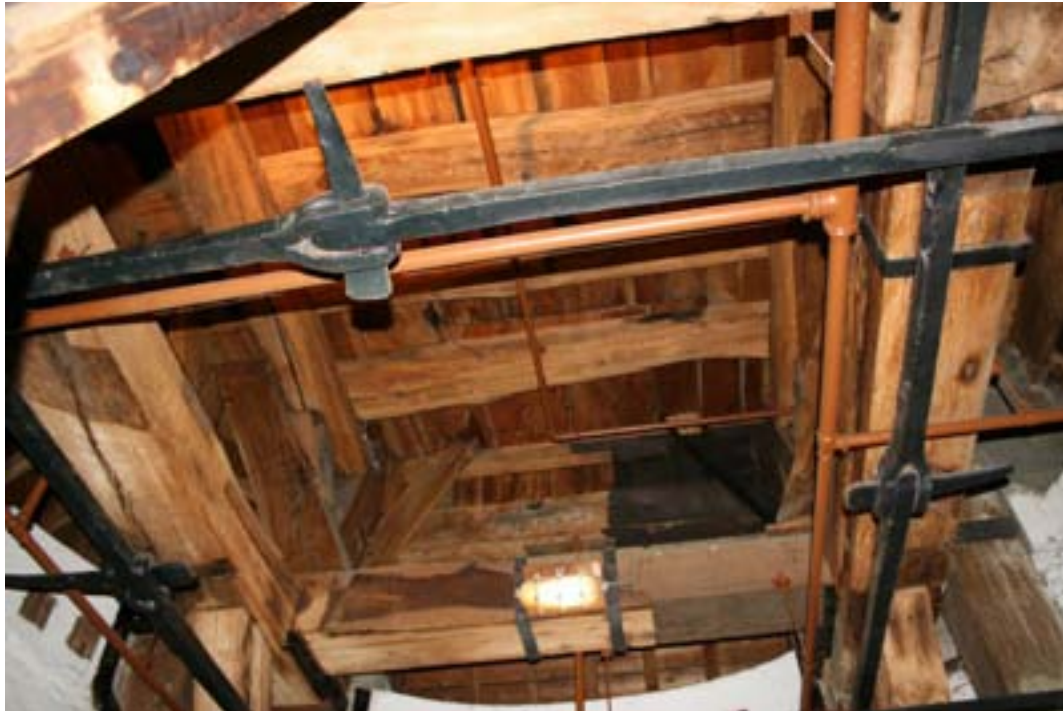
De houten constructie van de Munttoren.
