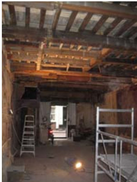
Lange Niezel 16, pand met gotisch houtskelet en kroonlijstprofileringen in de consoles van de tussenbalken (foto's BMA).
