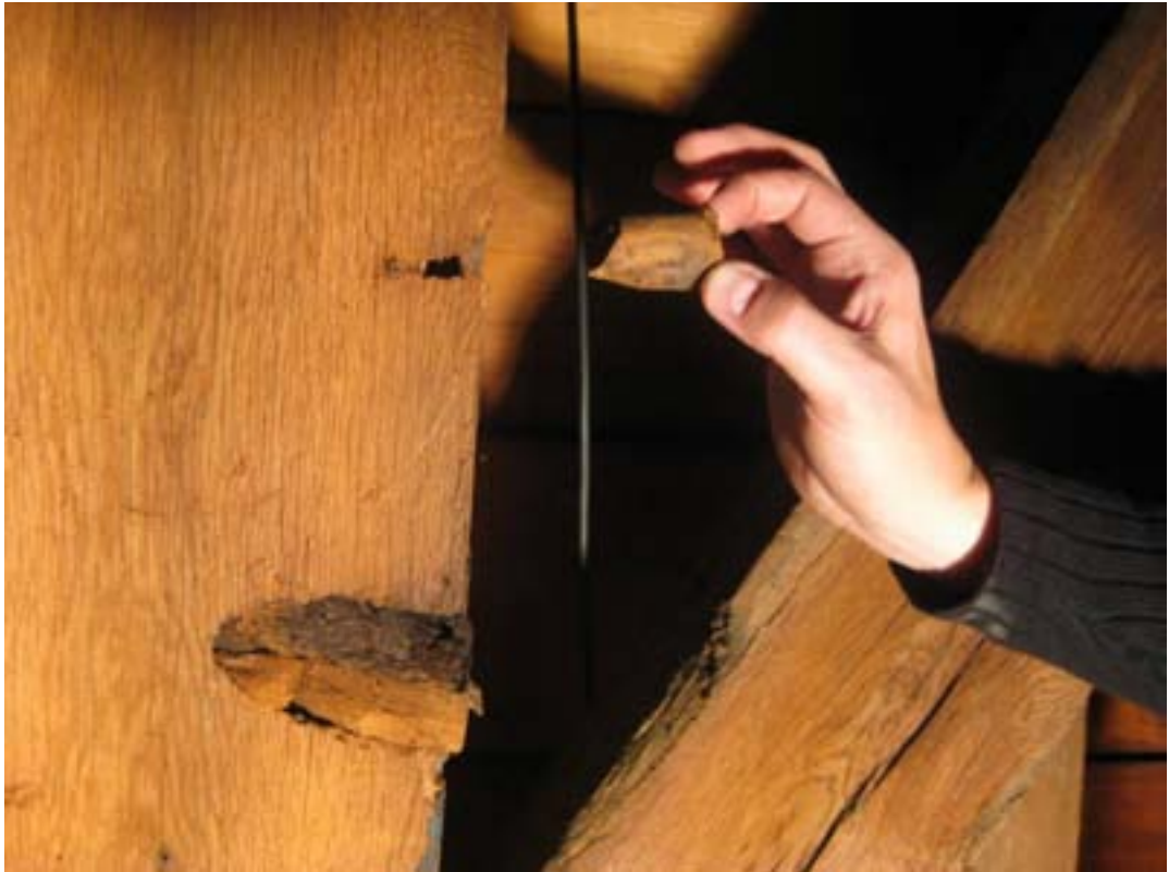
Voorbeeld van een doorgezaagd 'wisgat'. Aan de afgetopte onderzijde – links onder – is duidelijk te zien dat het gat met een lepelboor is aangebracht.
