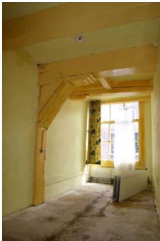
Warmoesstraat 42, voorhuis: houtskelet van circa 1570 en zware, traditionele kapconstructie van kort na 1615 (foto's BMA).
