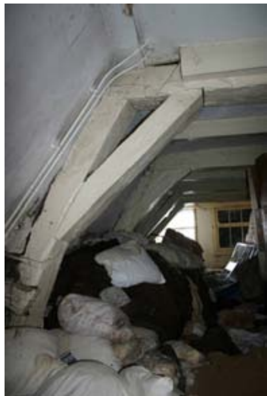
Warmoesstraat 42, voorhuis: houtskelet van circa 1570 en zware, traditionele kapconstructie van kort na 1615 (foto's BMA).
