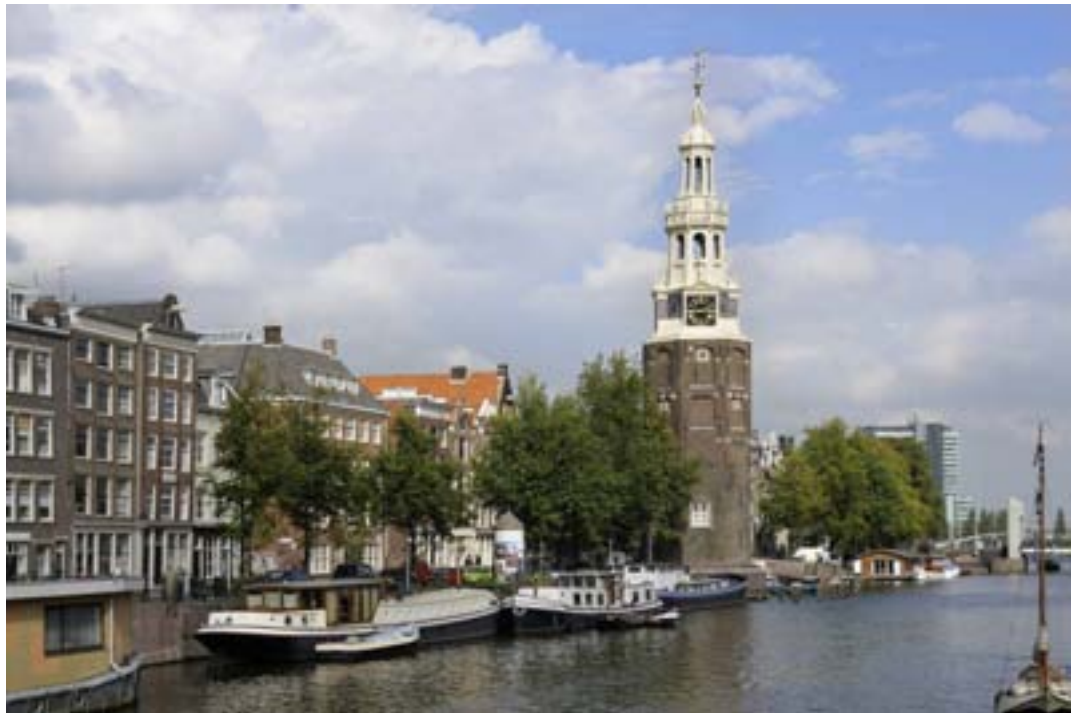
De Montelbaanstoren aan de Oude Schans in 2008 (foto Han van Gool/ BMA).
