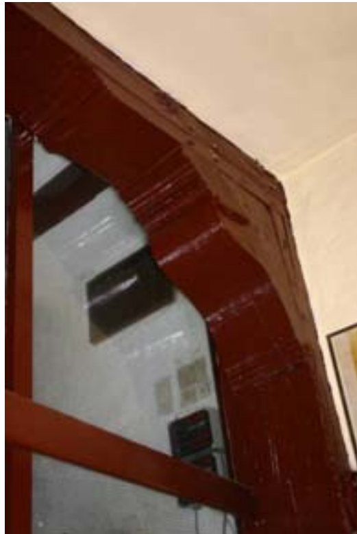
Warmoesstraat 42, zwanenhalskorbelen in het voorhuis (foto's BMA).
