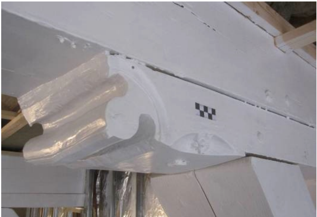
Gotisch peerkraalsleutelstuk op de eerste verdieping (foto David Derksen/ BMA).
