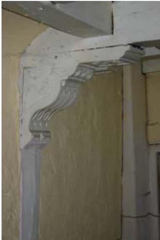
Warmoesstraat 42, zwanenhalskorbelen in het voorhuis (foto's BMA).
