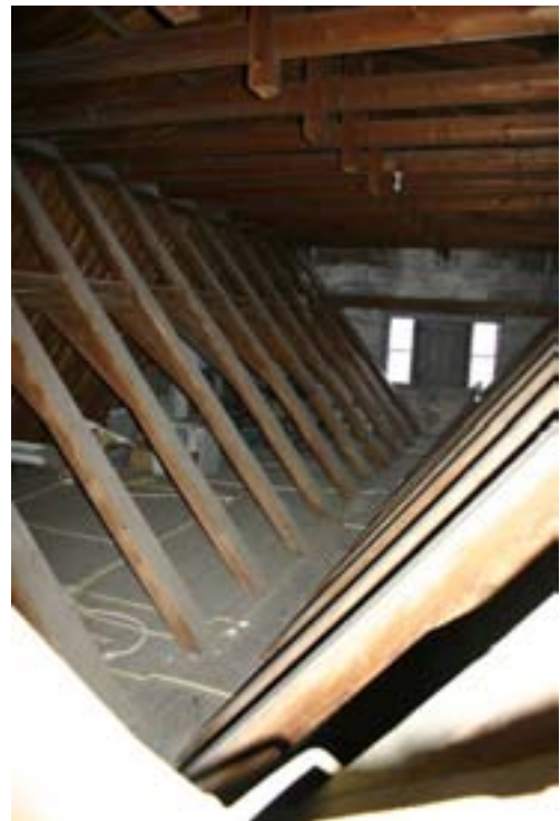
Herengracht 481. Rechts de zeventiende-eeuwse kapconstructie met de laatnegentiende-eeuwse overkapping erboven.
