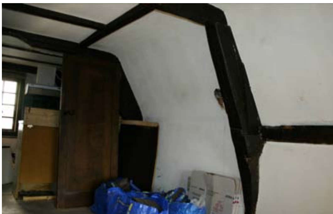
Impressie van de hergebruikte spanten.
