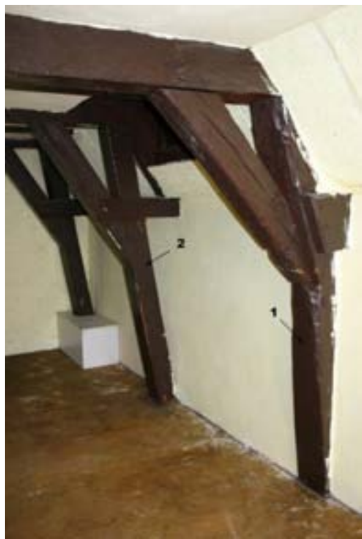
Warmoesstraat 38, voorgevel en kapconstructie. Rechts (cijfer 1) eiken krommer uit 1535-1538, links (cijfer 2) stijl van circa 1650 (foto's BMA).
