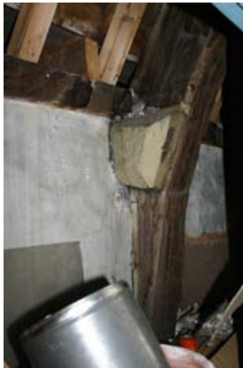
Kloveniersburgwal 47; voorgevel en gezaagde kromstijl in de kap van het rechter bouwdeel.
