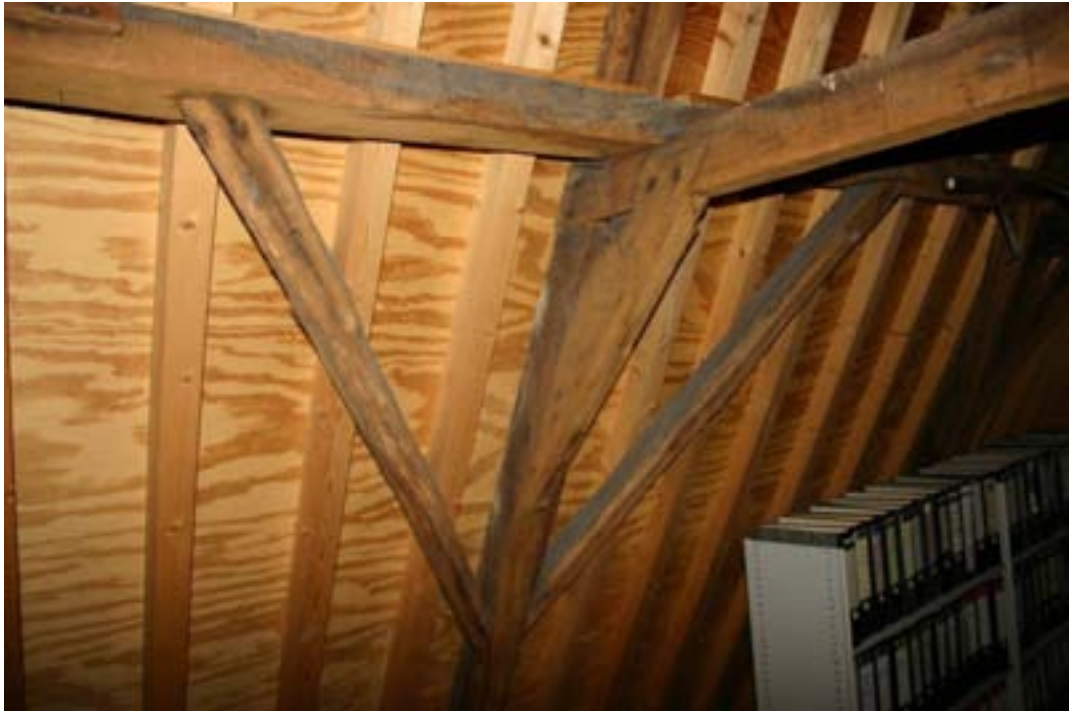
Kloveniersburgwal 47; blik in de kapconstructie van het rechter bouwdeel. De korbelen zijn met halfhoutse verbindingen aan de debalken bevestigd.
