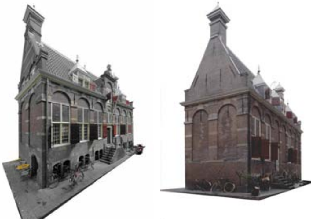
Het Korenmeetershuis vanuit het westen en het oosten gezien (foto Han van Gool/ BMA).
