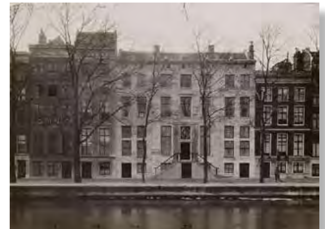
Onder: idem, na de verbouwing, situatie in 1940 (SAA)
