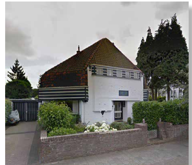
Onder: Het Veerhoff-Kothehuis in Hilversum zoals het er na enkele verbouwingen bijstaat; links het ontwerp van De Klerk
