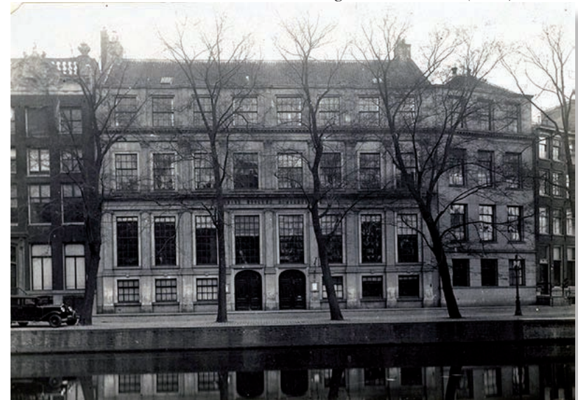
Onder: Coymanshuis verbouwd tot H.B.S. Alle ramen zijn vergroot ten koste van de classicistische gevelelementen (SAA)
