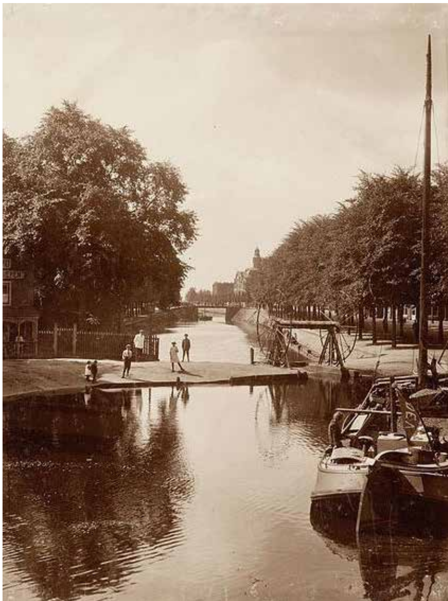
Boven: De aansluiting van de Boerenwetering op polderniveau met de Mennonietensloot, die op stadsniveau lag. Rechts in beeld de overhaal, links buiten beeld is nog een sluis naar de Singelgracht.
