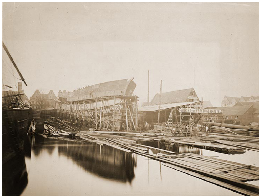
Het Compositie Clipper Barkschip “Tjerimai”, circa 1000t, in aanbouw op de werf De Nachtegaal van Jan F. Meursing, Grote Bickersstraat 78 (Atlas SAA)
