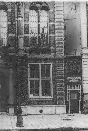
De Zuigelingen-Inrichting en Kinderhuis, Plantage Middenlaan 31, in 1932. Links is de babyzaal, rechts de kamer van directrice Henriëtte Pimentel. Uiterst rechts de deur van het gangetje waardoor de kinderen gebracht en gehaald werden. Op de eerste verdieping de zaal van de synagoge.
