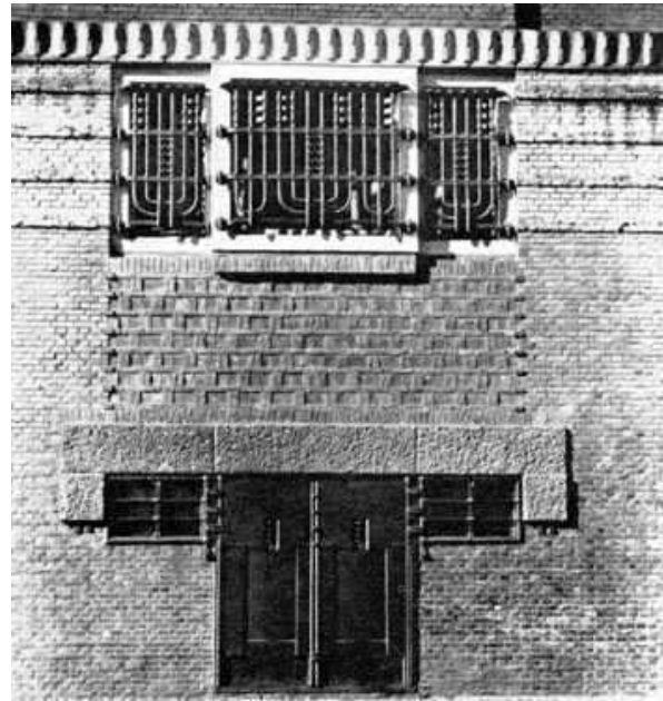
Smeedwerk aan Administratiegebouwe Gerzon, Spuistraat
