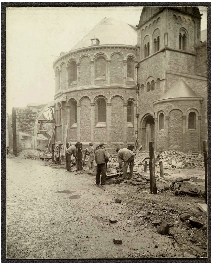
Boven: Afbraak van de luchtbogen aan de apsis (Stokstraat, ± 1905). Op dat moment is de noordelijke koortoren al gereconstrueerd. Rechts: Op de foto de zuidoostelijke transeptkapel tijdens de restauratie, 1888
