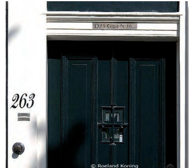
Bij renovatiewerkzaamheden aan het pand Herengracht 263 ontdekte men een huisnummer uit 1796. Het nummer betekent: District 13 Grondvergadering 24 huis No. 181. De laatste één is verdwenen maar kaarten met ingeschreven huisnummers duiden op No. 181. Foto: Studio Roeland Koning
