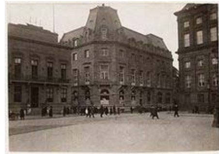
Afbeelding 9 Het gerealiseerde gebouw van de Groote Club
