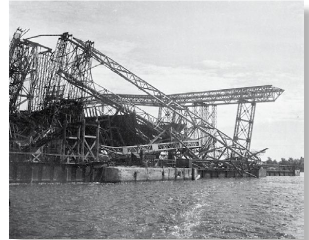
Boven: Vernielingen aan o.a. de hoogbanen, aangericht door de Duitsers in september 1944
