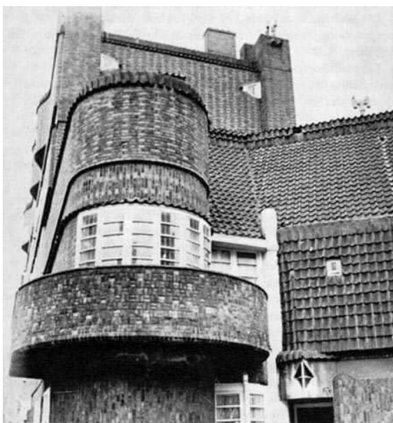
Talrijk zijn de metselverbanden, die De Klerk hier heeft gebruikt (hoek Hembrugstraat/ Oostzaanstraat)
